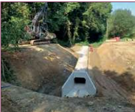
Exemple de pont cadre
